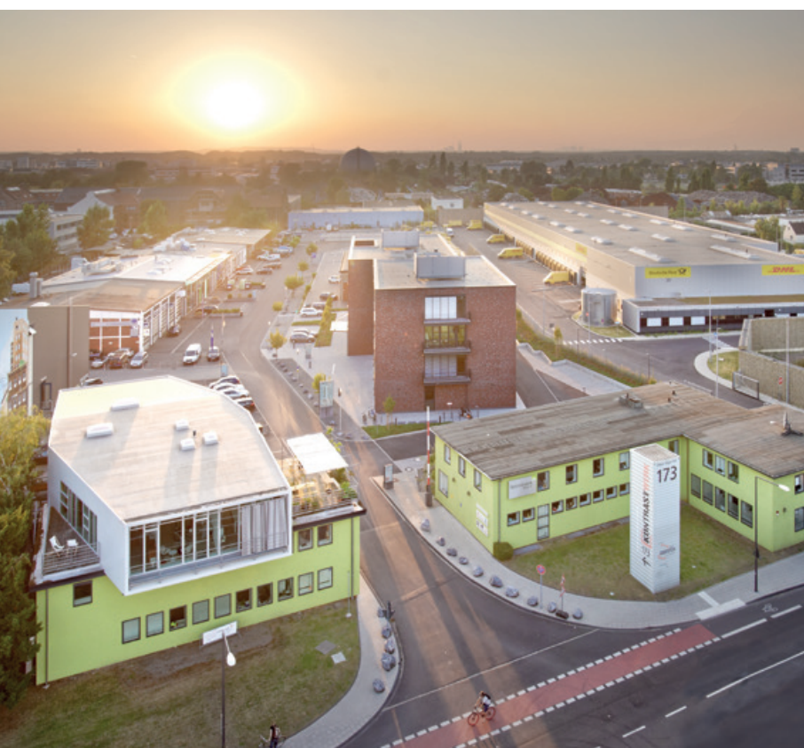
Moderne Ausführung eines Gewerbeparks am Beispiel des Kontrastwerks in Köln (Foto: Ingo E. Fischer, Quelle: Aurelis)
