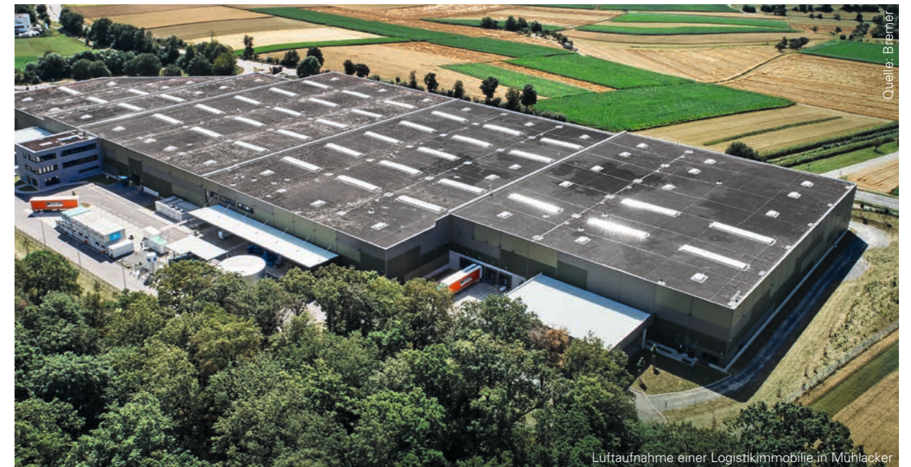
Luftaufnahme einer Logistikimmobilie in Mühlacker
