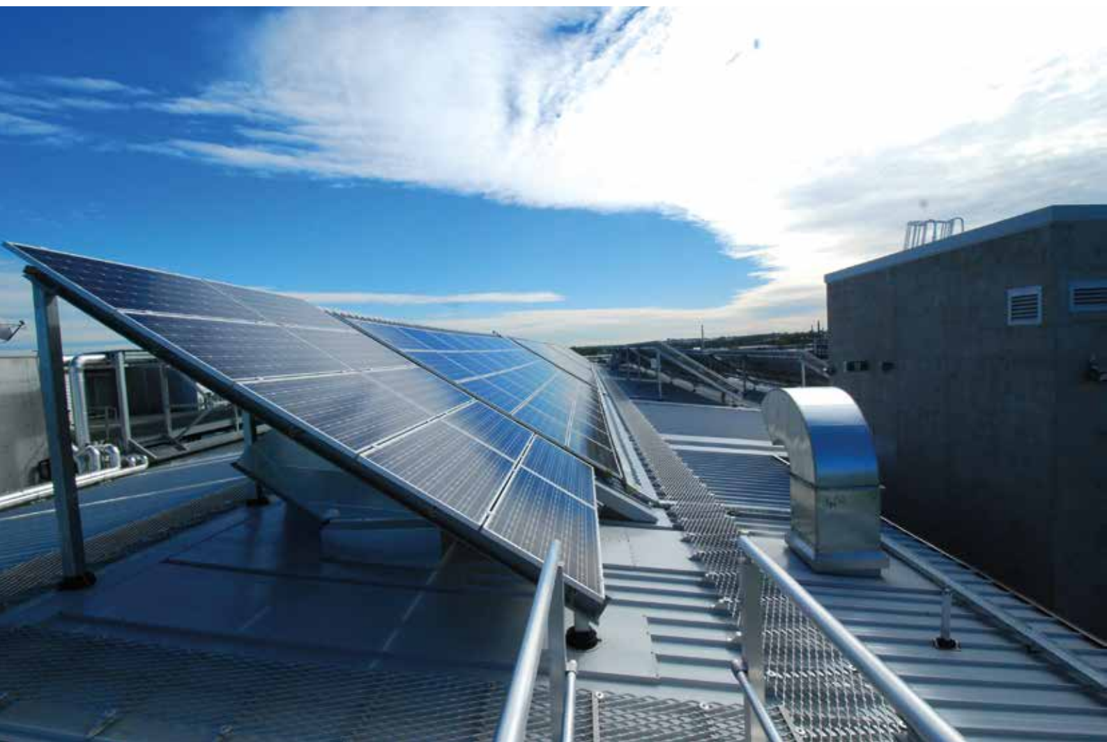
Abb. 52 LOGISTIKHALLE MIT PHOTOVOLTAIKMODULEN
