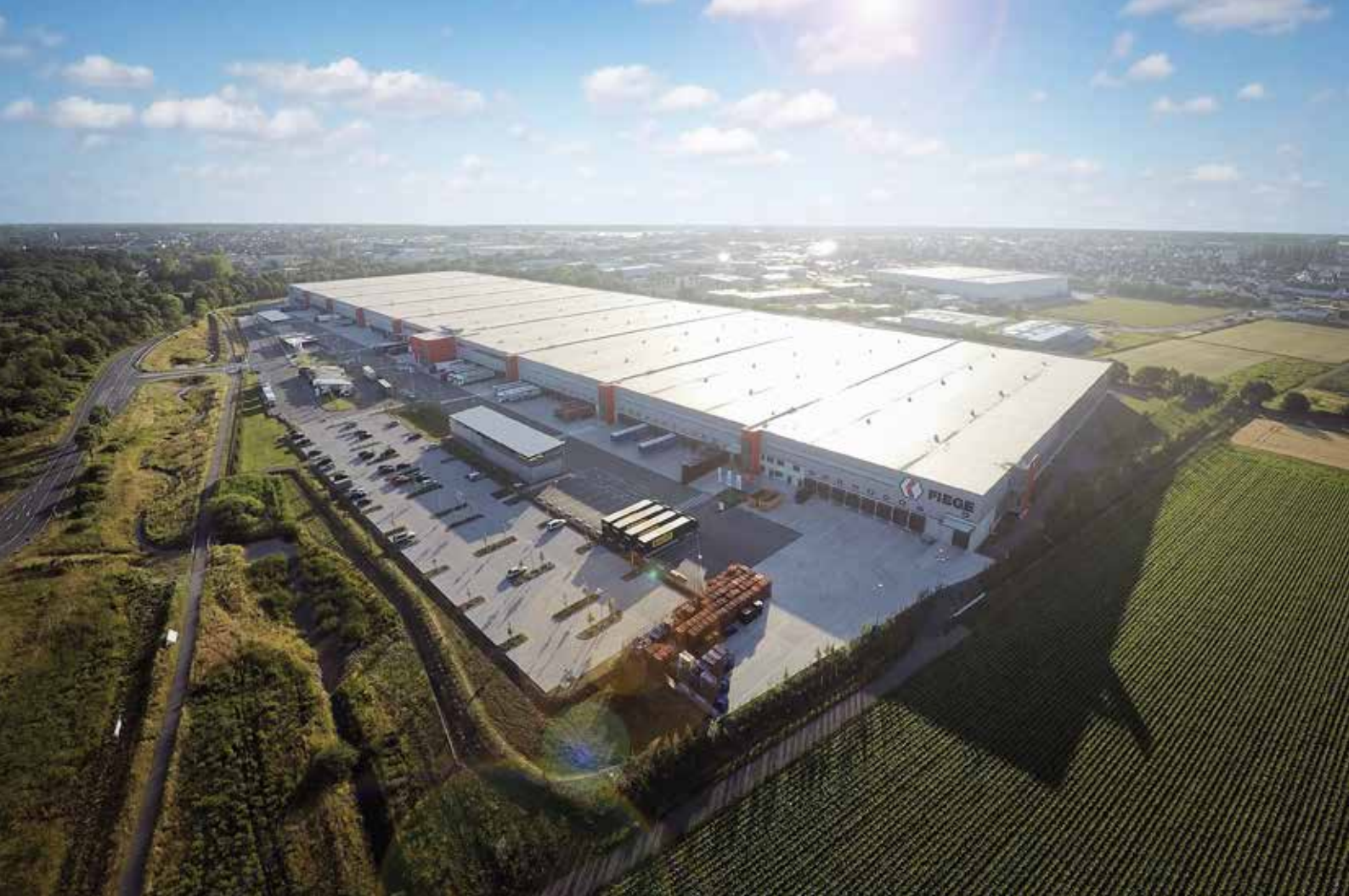
Abb. 53 DGNB-PLATIN ZERTIFIZIERTER NEUBAU DES FIEGE LOGISTIKZENTRUMS RHEIN-MAIN (DIEBURG)
