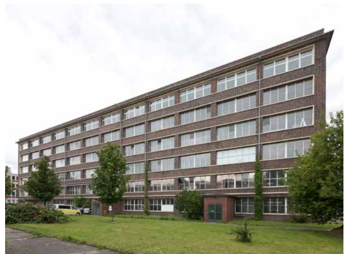
Gebäude des Sirius Park Berlin Tempelhof
