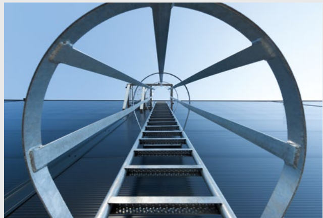
FEUERLEITER DES GREENFIELD LOGISTIKZENTRUMS IN ACHERN
